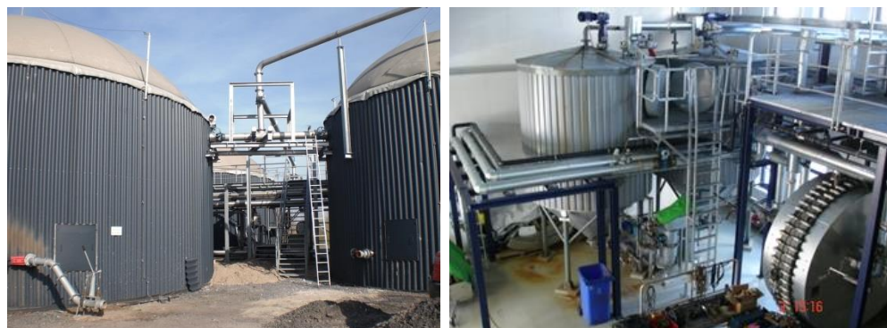
Abbildung 3: Blick auf wesentliche Anlagenkomponenten anaerober Nassvergärungsanlagen in Deutschland (links: Gärbehälter, rechts: Vorbehandlungsstrecke, Bildquellen: Tim Hermann; Intecus)
