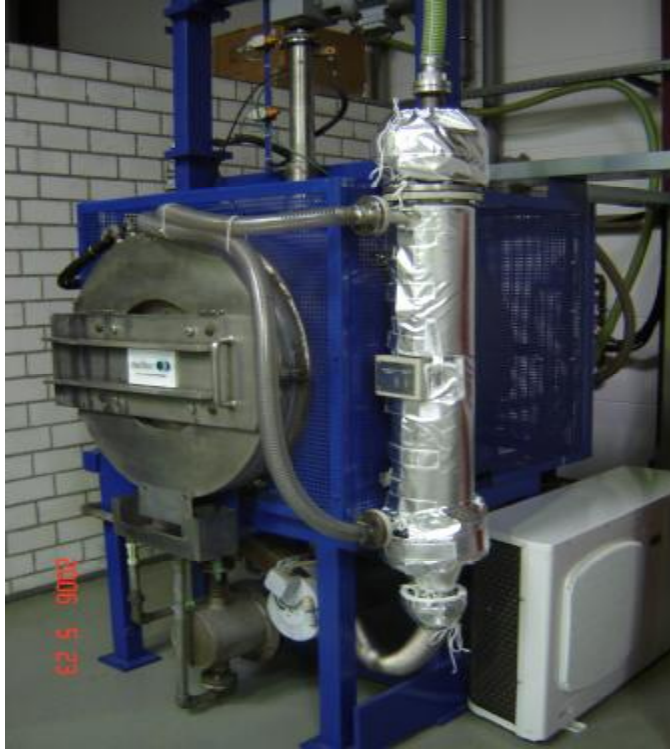
Abbildung 27: Elektrolytkondensator mit Kältemaschine
