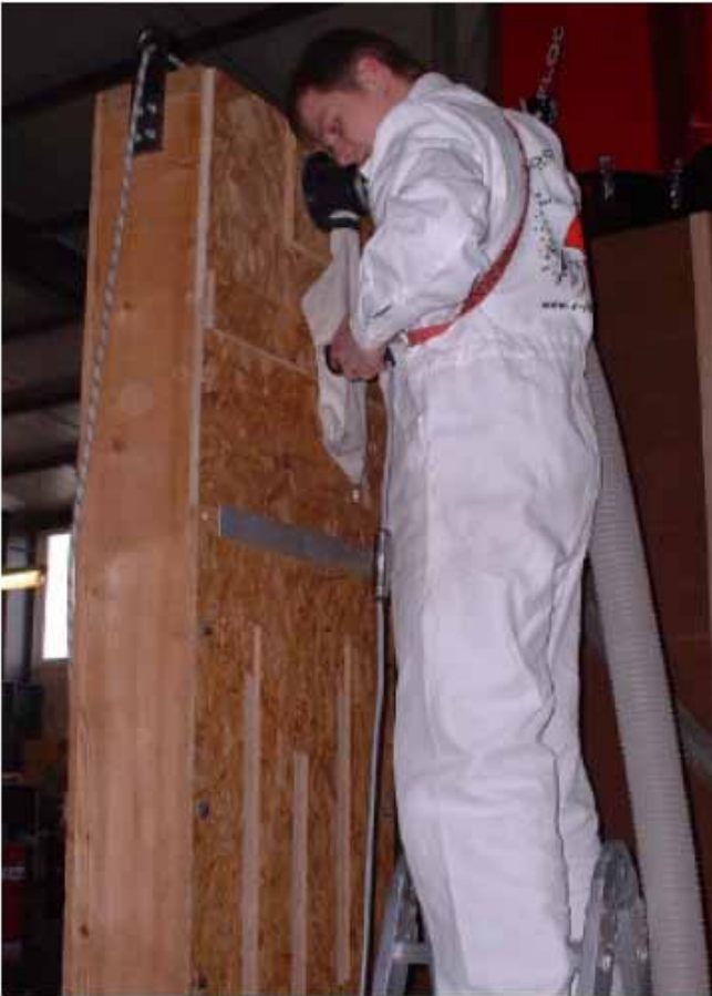
Abbildung 23: Einblasen von Hobelspänen in eine Ständerwand.
