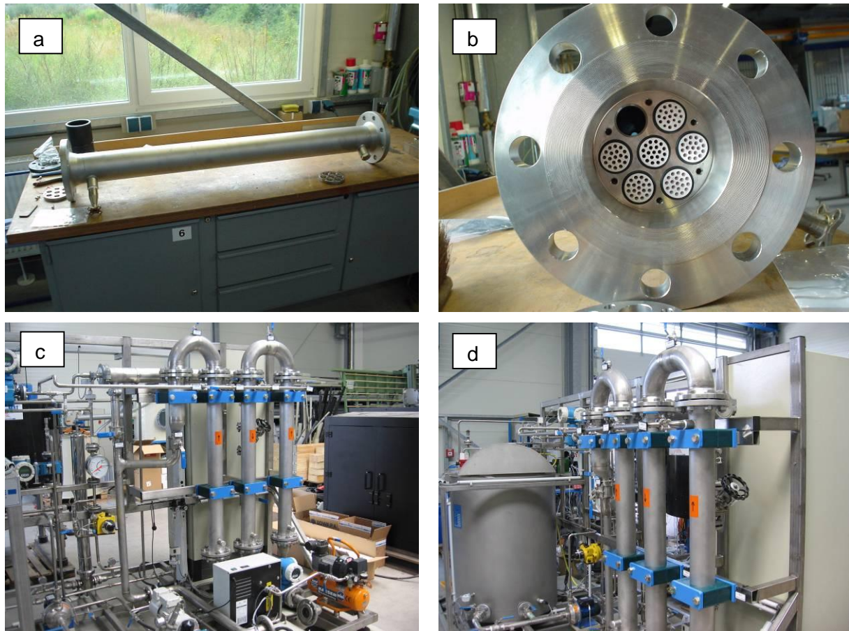
Abb. 15: Durchführung des Anlagenumbaus
