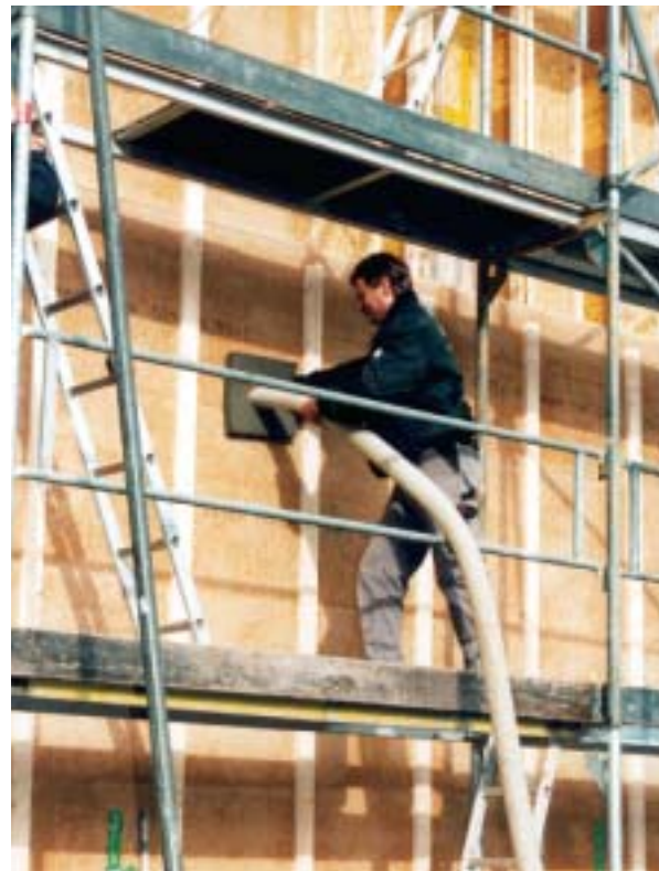
Rationelle Verarbeitung loser Dämmstoffe aus Holz
