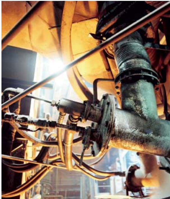
In die Kupolofenblasform integrierter Sauerstoffbrenner
