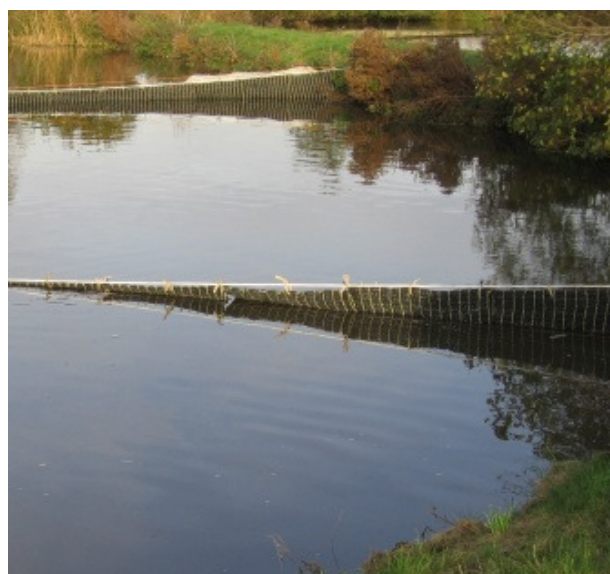
Abbildung 2: Abwasserteichanlage Berel mit 2 aufgespannten textilen hydraulischen Barrieren aus extrem grobem Rechts-Rechts-Kettengewirken mit einer Schlingenseilstruktur als Schussmaterial.
